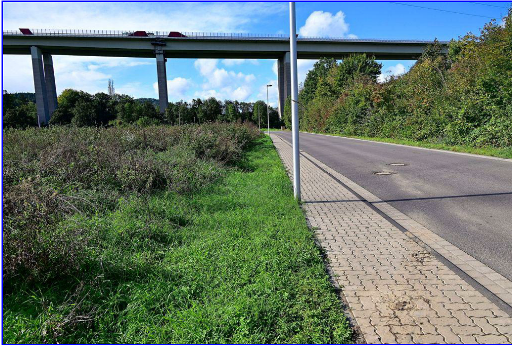
Abb. 12: Rain TF11 (BT HC0) entlang des Bürgersteigs der TF01
