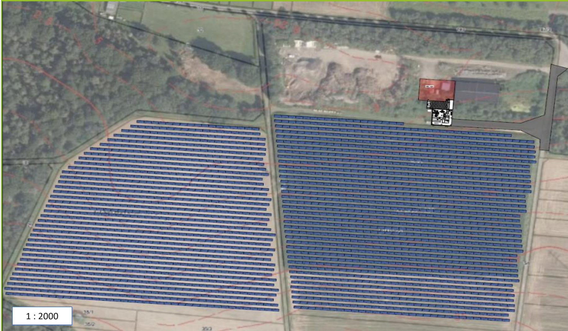
Beispiel Solarthermiefeld mit Biomasseheizwerk Bengener Heide
