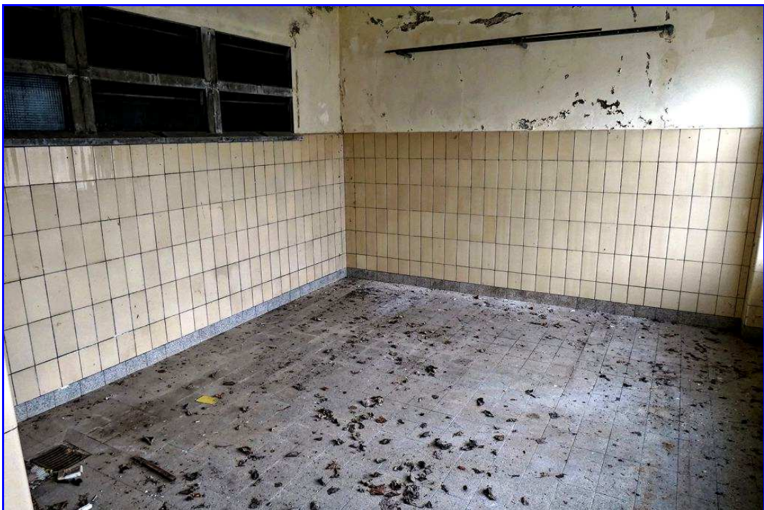
Abb. 53: Milchküche in Gebäude N3
