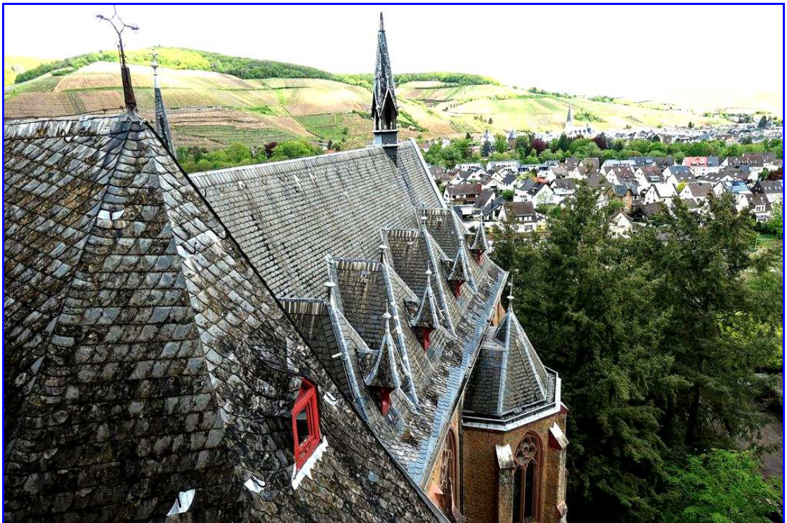
Abb. 18: Detailansicht des Dachbereiches des Kirchengebäudes, Blick Richtung Norden (im Hintergrund Ahrweiler mit der Laurentiuskirche)
