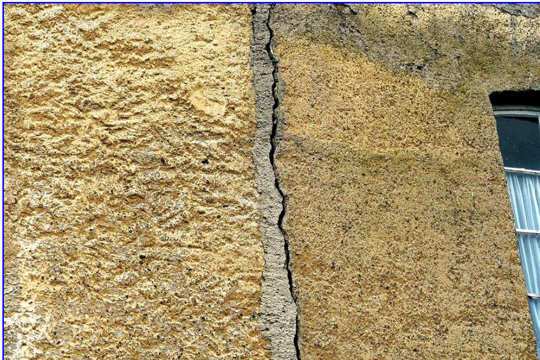
35 Abb. 75: Mauerfuge zwischen N2 und N3
