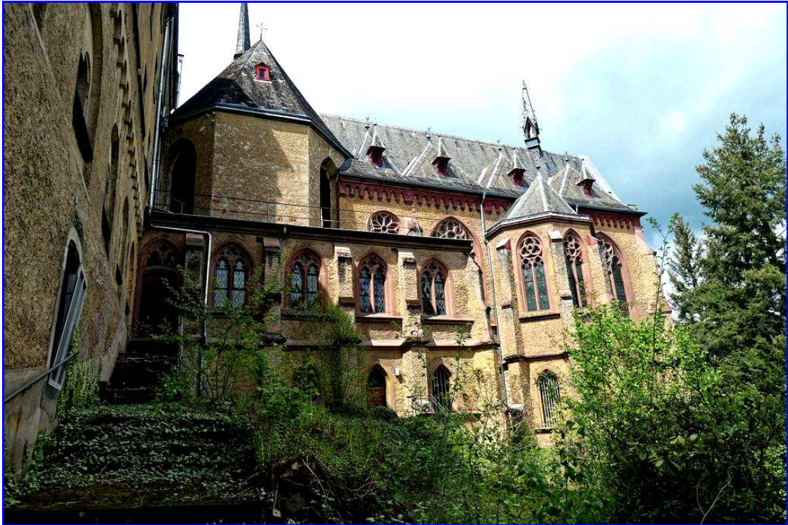
Abb. 17: Kirchengebäude im Nordteil des Gebäudekomplexes
