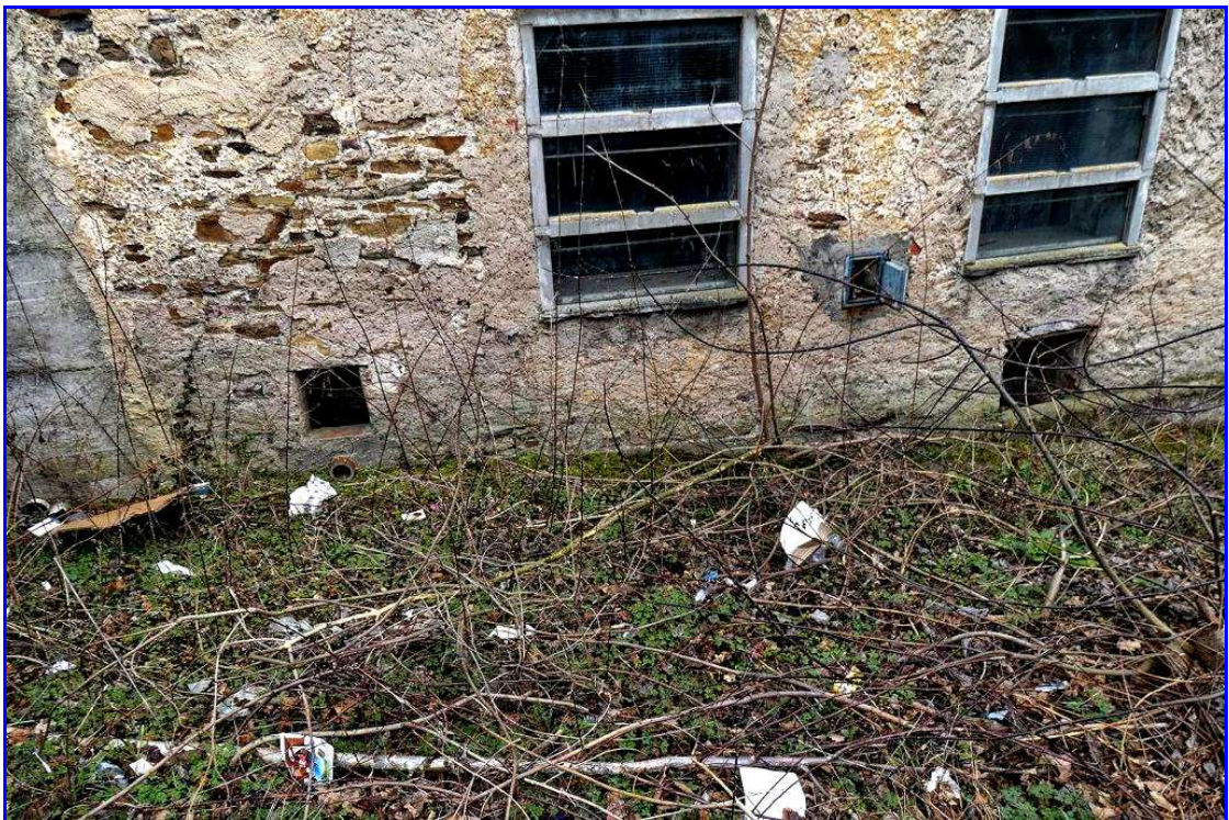
Abb. 74: Lüftungsöffnungen des Kellers aus Abb. 62 (Öffnungen in Bodennähe)
