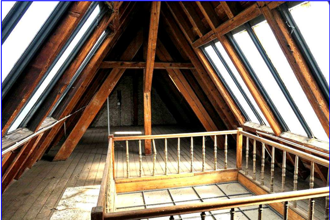
Abb. 65: Befensterter Dachboden des Nordteils
