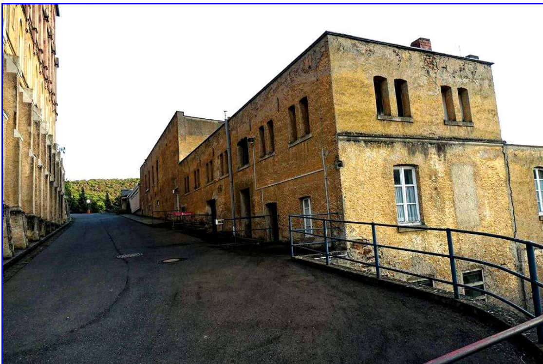
Abb. 24: Nebengebäude W der Zufahrtsstraße zum Eingangsbereich
