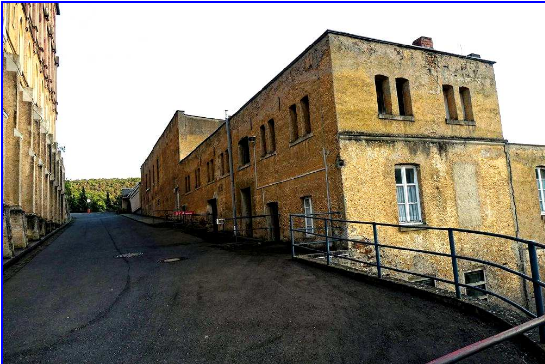
Abb. 24: Nebengebäude W der Zufahrtsstraße zum Eingangsbereich
