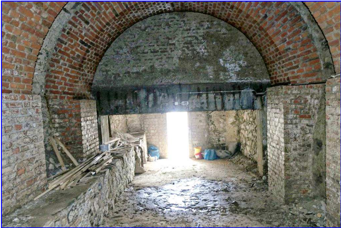
Abb. 71: Keller östlich der Zufahrt
