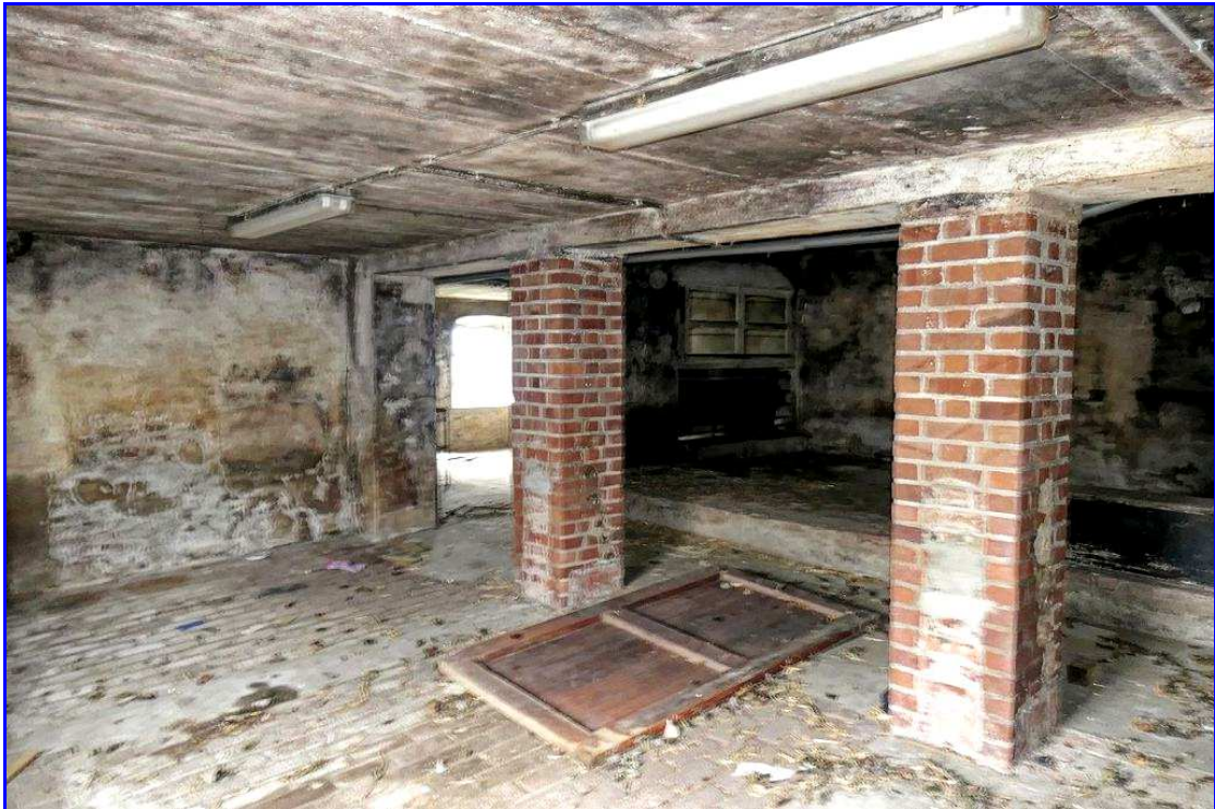
Abb. 52: Schweinestall in Gebäude N3
