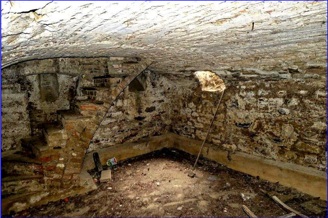
Abb. 73: Gewölbekeller unter Haus N2 mit Zugangstreppe und Lüftungsöffnung
