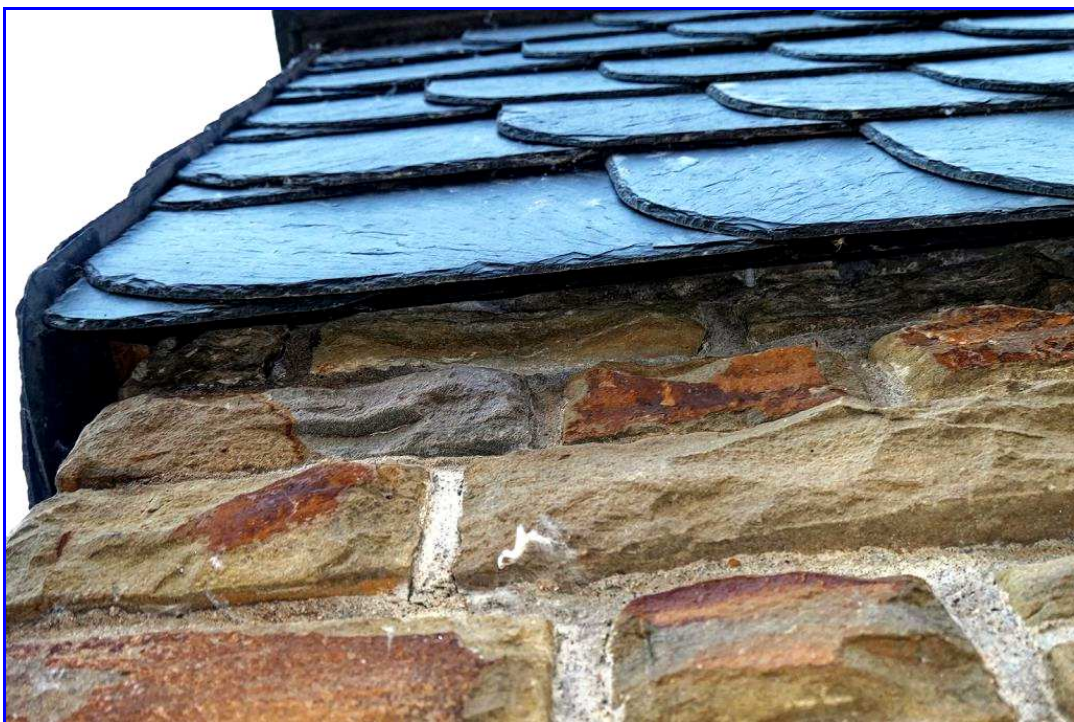
Abb. 81: Schieferverkleidung über Bruchsteinverblendung
