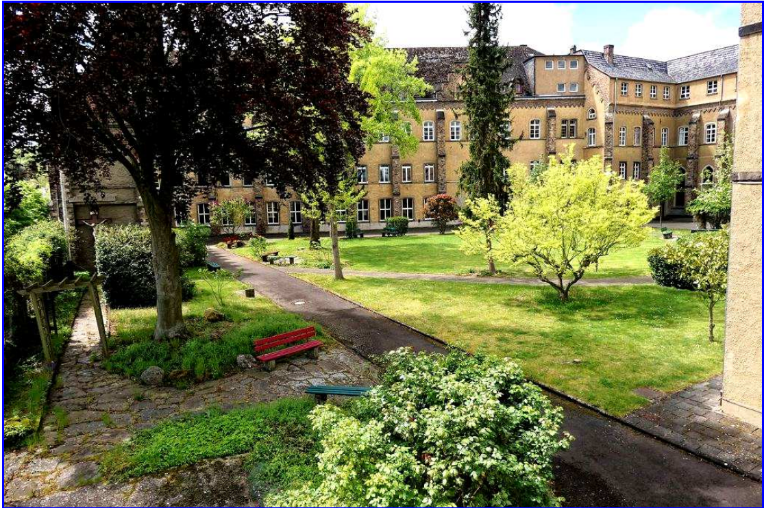
Abb. 23: Klostergarten, Blick auf die umschließenden Gebäude
