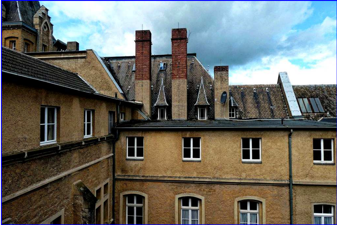
Abb. 19: Detailansicht Dachbereiche der Wohngebäude
