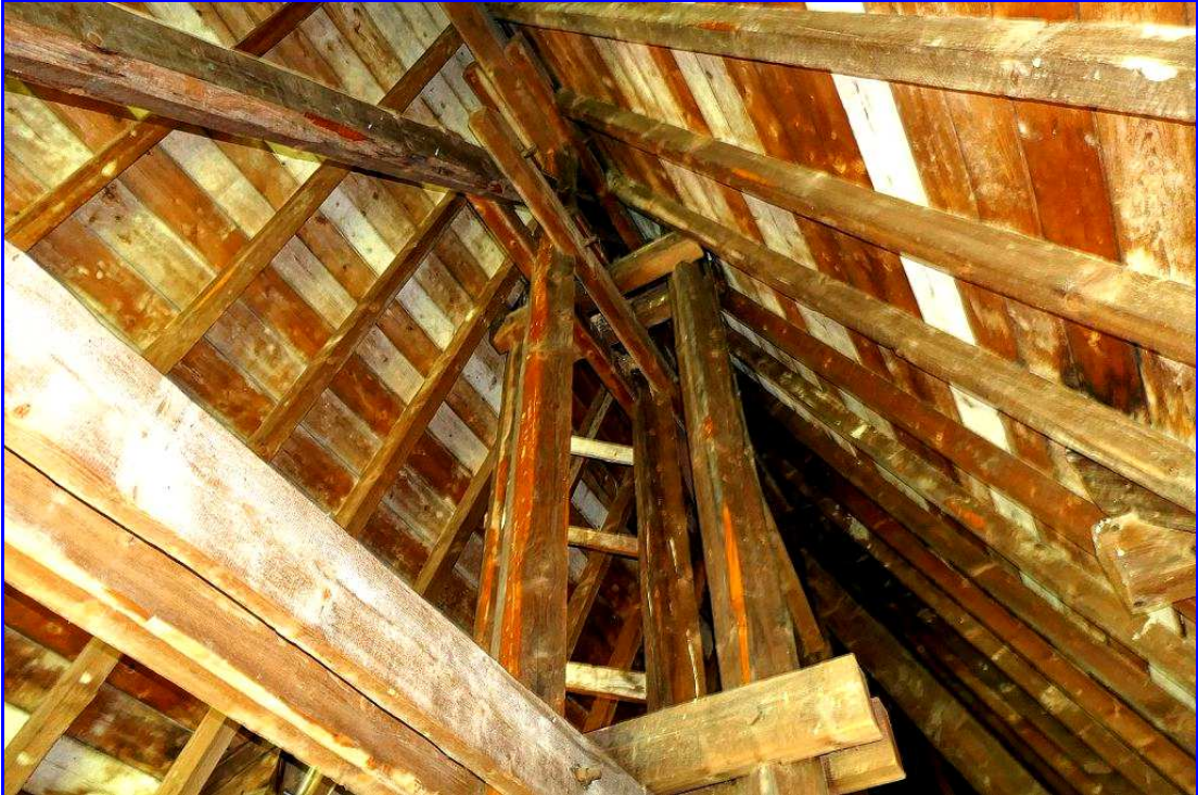
Abb. 57: Dachstuhl Kirchengebäude mit Stützen für den Glockenturm
