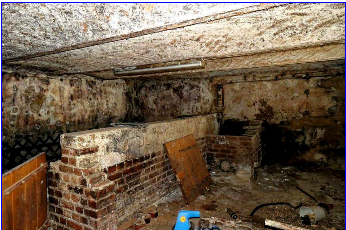
Abb. 51: Kuhstall in Gebäude N3
