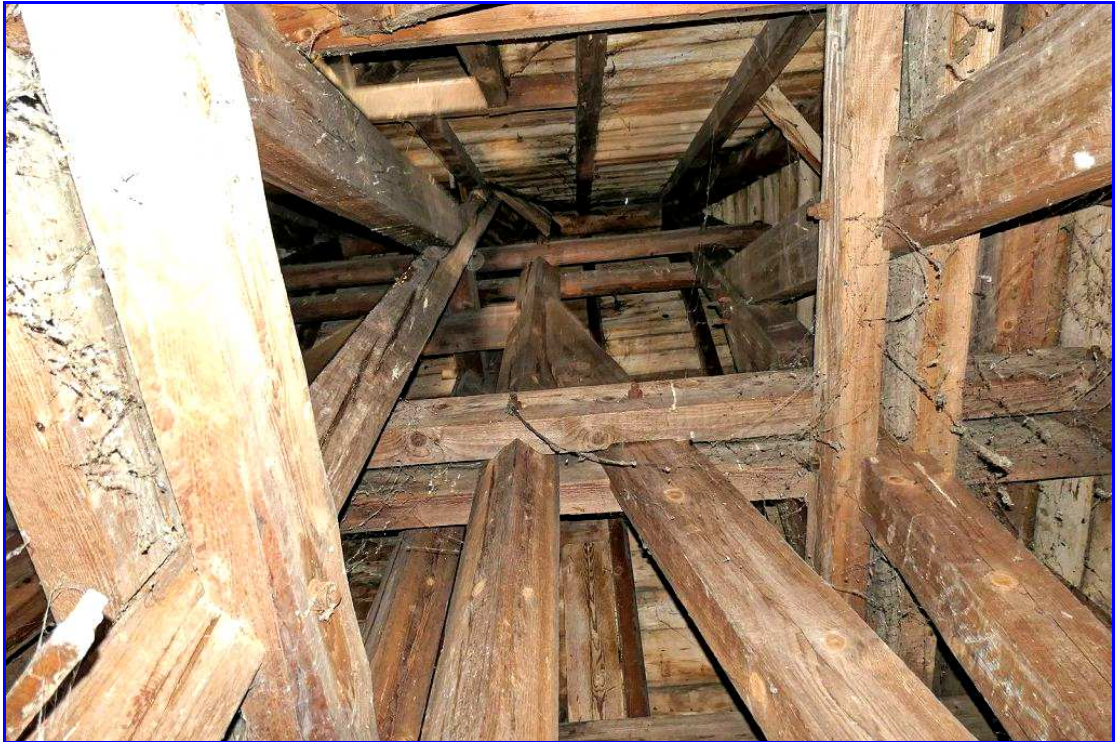
Abb. 55: Dachstuhl im „Falkenturm“
