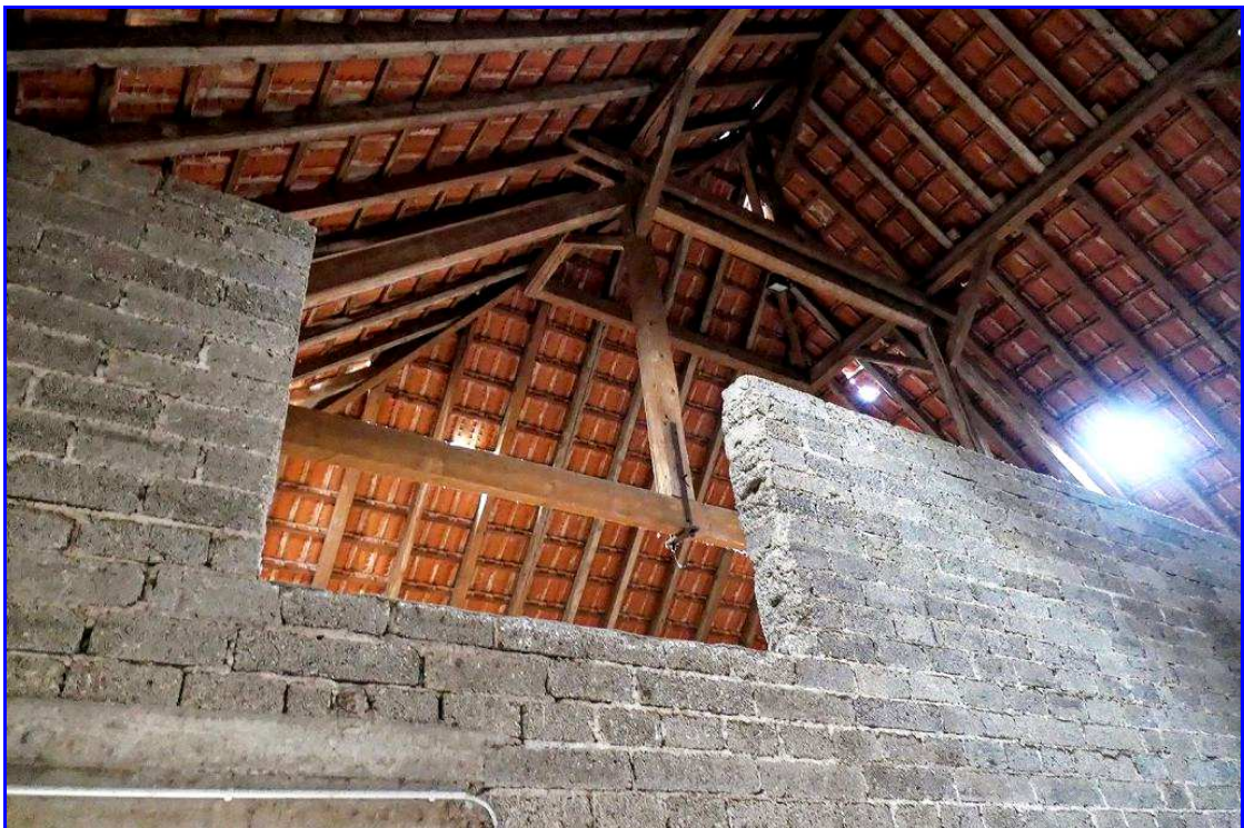
Abb. 67: Scheune N1 Südteil
