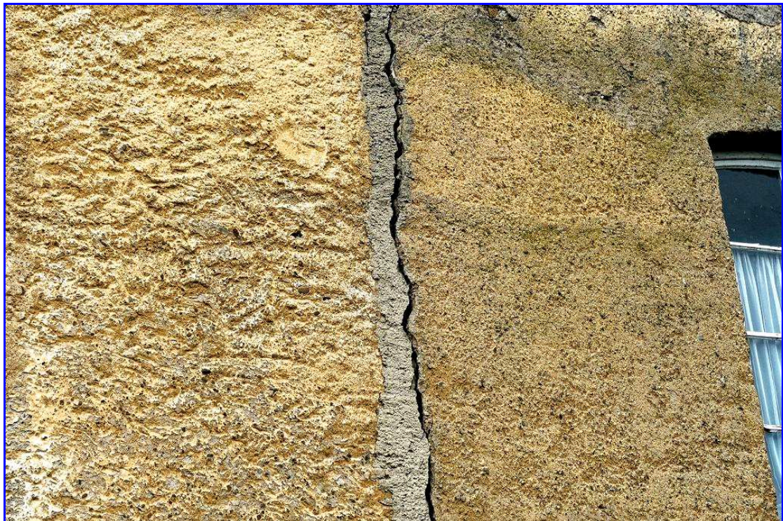
35 Abb. 75: Mauerfuge zwischen N2 und N3
