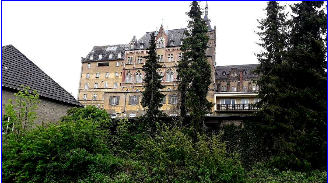
5 Abb. 15: Westfront des Hauptgebäudes, links im Bild Wirtschaftsgebäude (Scheune) rechts die ehemalige Hausmeisterwohnung
