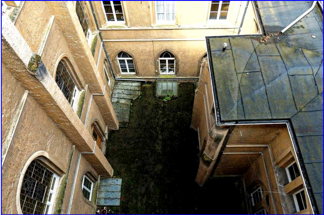
Abb. 21: Lichtarmer Innenhof im Nordteil des Komplexes
