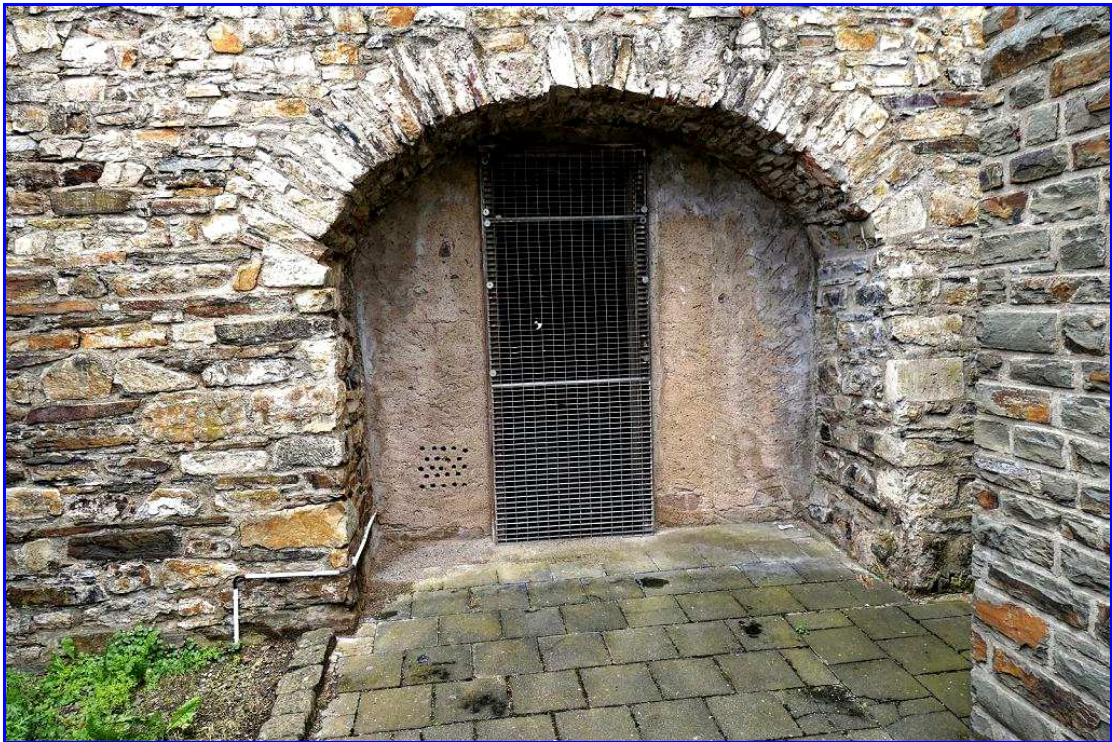
Abb. 70: Eingang Keller östlich der Zufahrt
