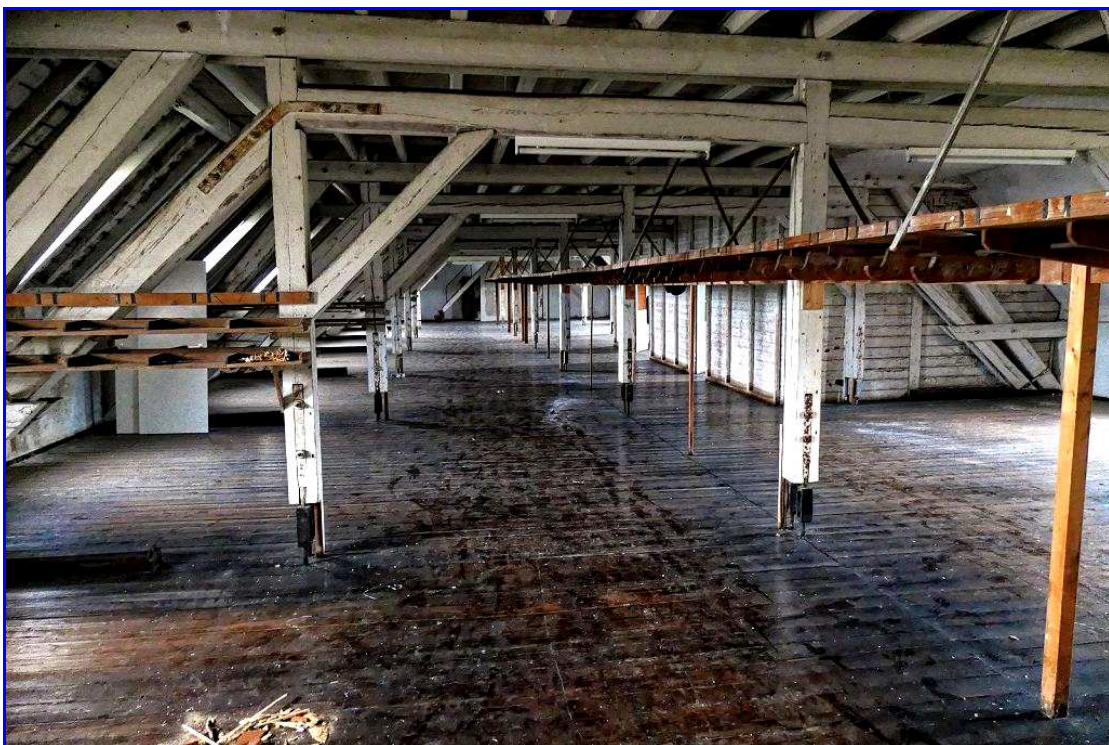
Abb. 62: Genutzter Dachboden des Gebäudes 8
