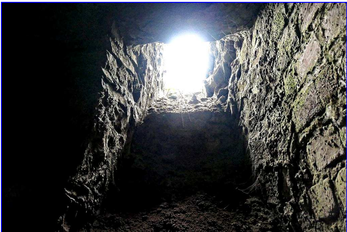
Abb. 72: Lüftungsöffnung in Gewölbekeller
