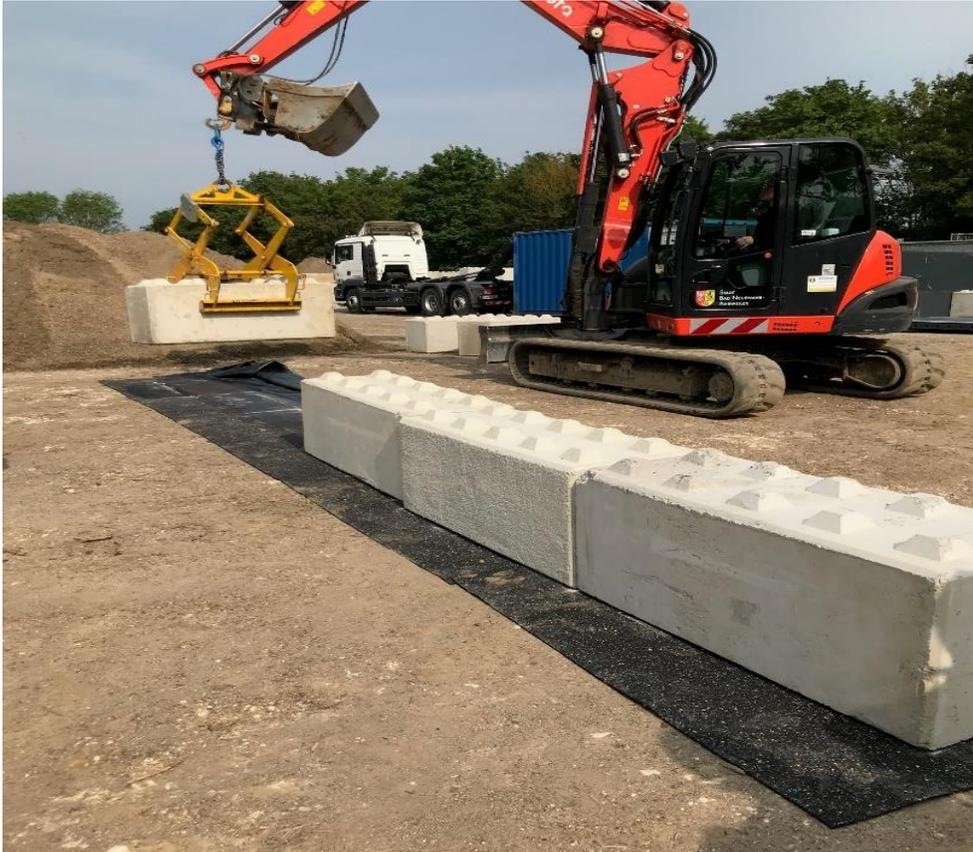
Hebegerät für die Errichtung von temporären Schutzwällen
