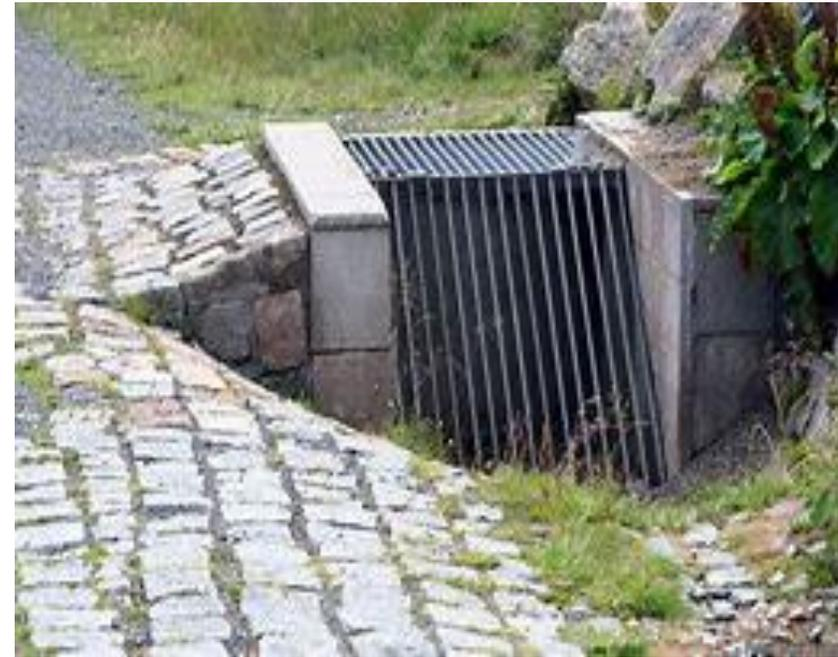
Durch die schräge (dreidimensionale) Anordnung der Gitterstäbe wird das anfallende Treibgut im Schadensfall von der Strömung hoch geschoben. Die Gefahr der Verstopfung wird so deutlich reduziert.
